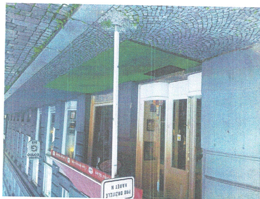
Zrušení prosvětlení pomocí sklobetonu v chodníku Klíperově ulici
