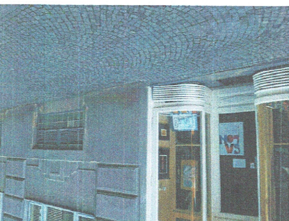
Obdobá větrání angl. dvorku atyp. žaluziemi (prosvětlení sklobetonovými tvárniciemi zrušeno)
